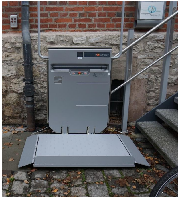
Position 2 Plattform ausgeklappt Beide Klappen und Sicherungskappen sind offen
